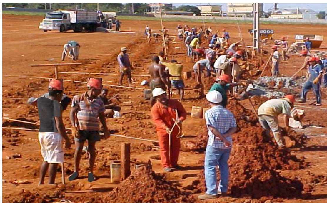
Foto 3.11 Escavação manual das estacas de Solo-cimento Plástico
