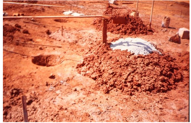
Foto 3.13 Traçagem manual do SCP
