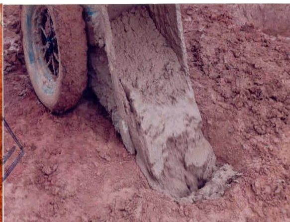
Foto 3.14 Consolidação do solo fofo na ponta Foto 3.15 Lançamento do SCP
