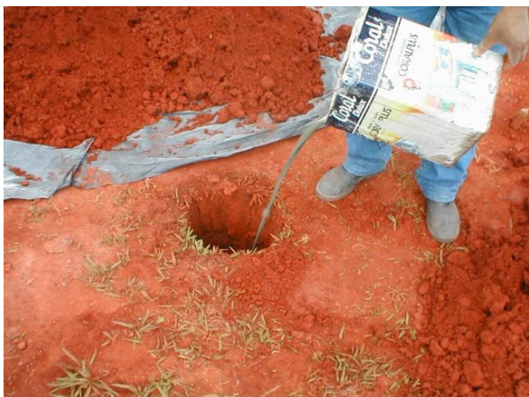
Foto 3.14 Consolidação do solo fofo na ponta Foto 3.15 Lançamento do SCP
