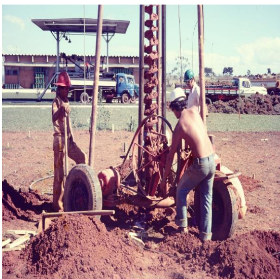
Foto 3.6 Escavação mecânica: por equipamento de fabricação
