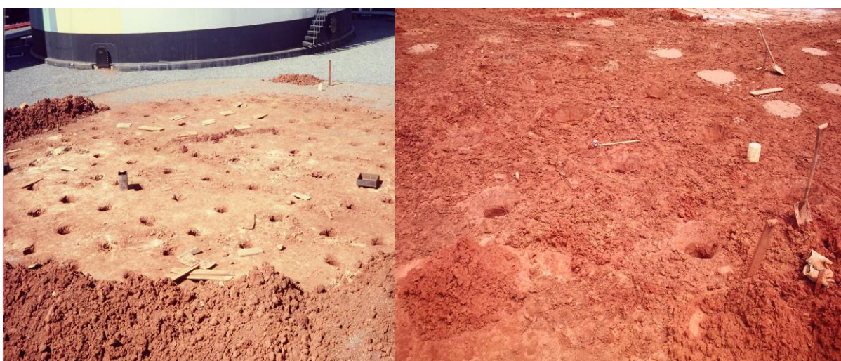
Foto 3.7 Aplicação do SCP como apoio para Radiers de tanques de petróleo
