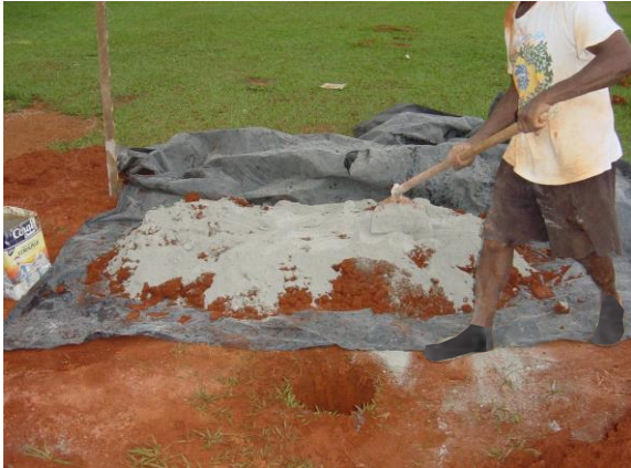
Foto 3.12 Preparo manual do SCP
