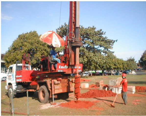
Foto 3.1- Escavação mecânica de estaca
