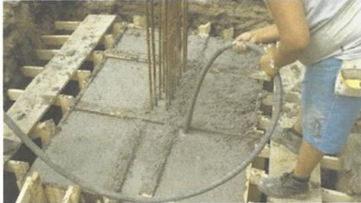
Lançamento e adensamento de concreto
