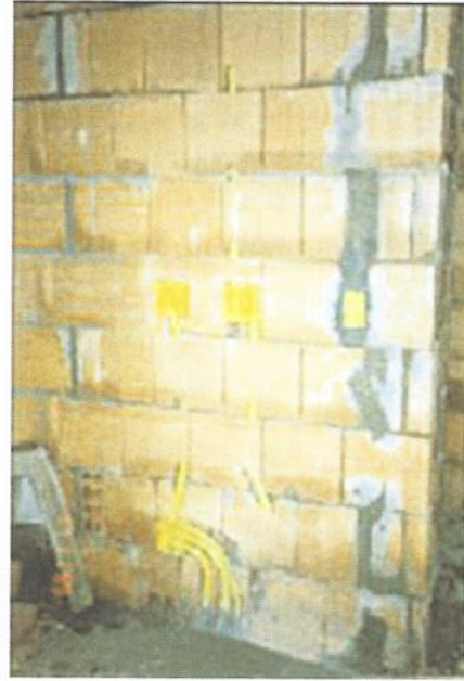
Hidráulica-Elétrica: tubulação embutida na execução da elevação das paredes
