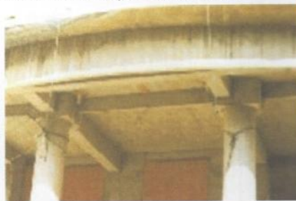
Laje Maciça e Blocos de Transição
