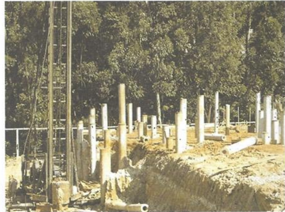
Estacas de concreto
