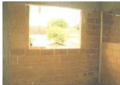
- Alvenaria de vedação racionalizada
