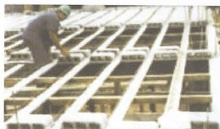
Operação de alinhamento das vigotas e painéis treliçados
