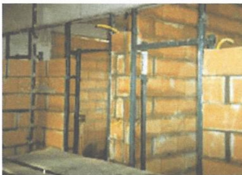
Elevação das paredes
