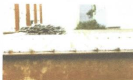
Operação de alinhamento das vigotas e painéis treliçados
